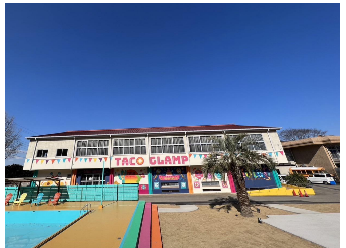
新体育館 (プレイルーム)
