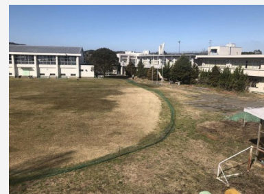
改装前の廃校となった旧高滝小学校
